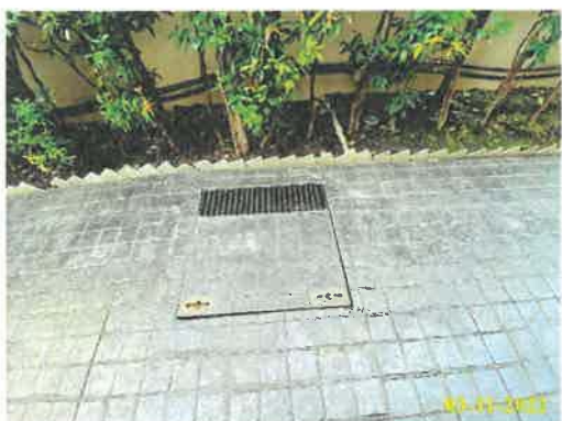
บ่อพักน้ำ (Manhole)
